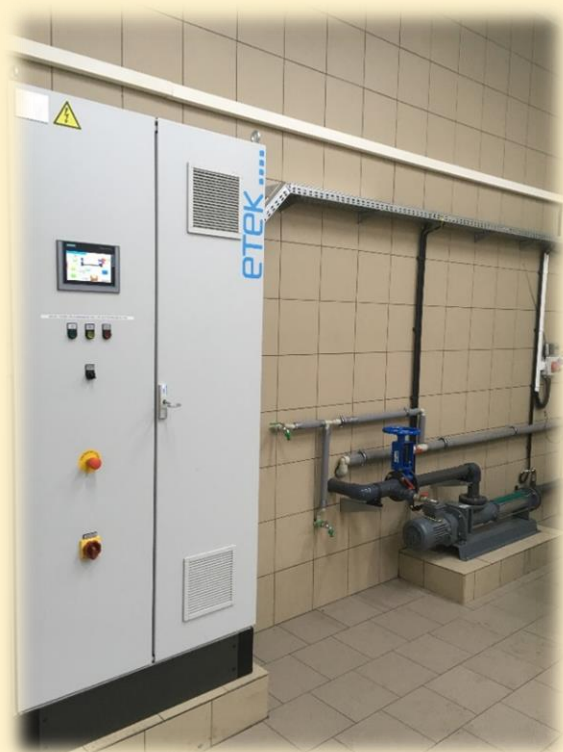
Szafa sterownicza, pompa nadawy oraz dotykowy panel sterowania prasą osadu
